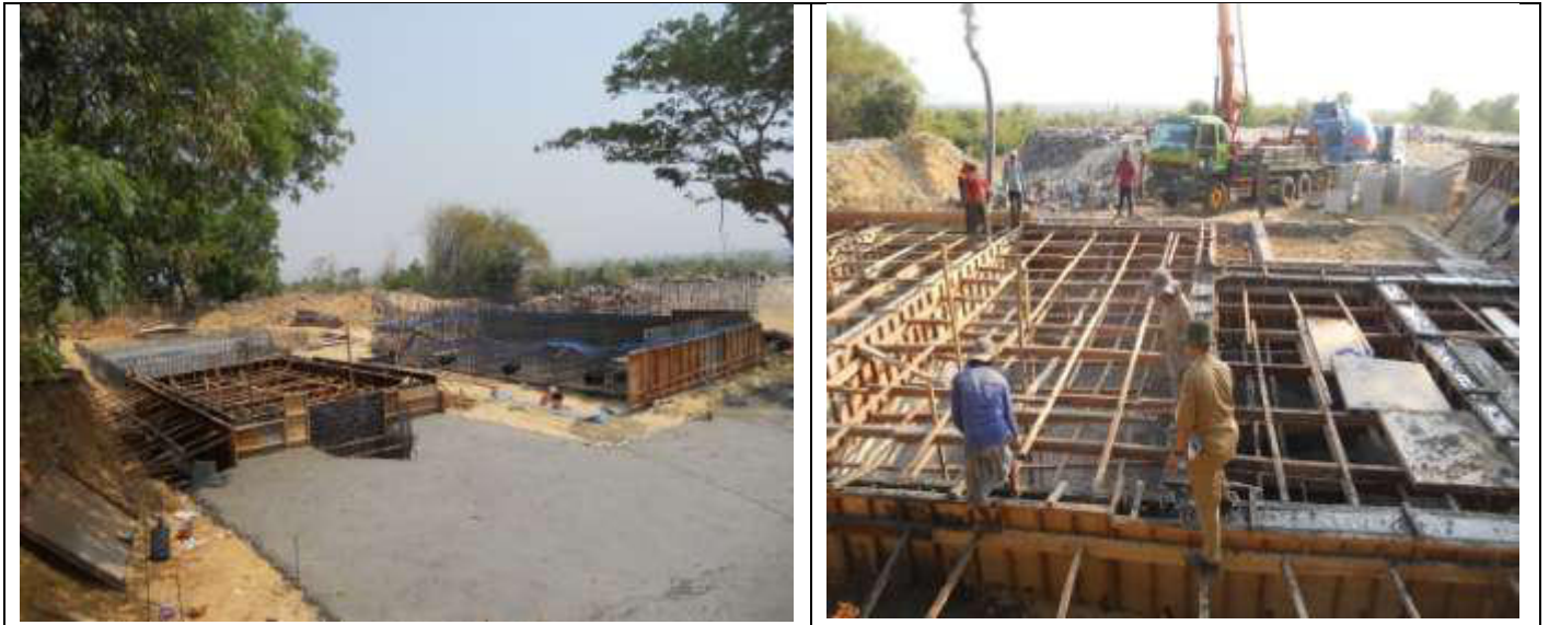
Sumber: Laporan Pembangunan IPLT, 2016
