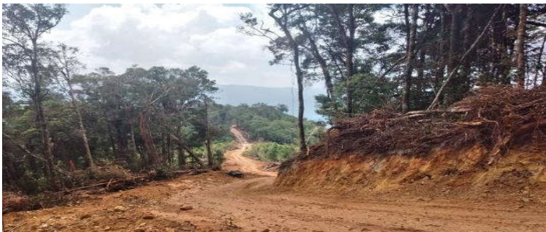
Gambar 8. Jalan di dalam kawasan hutan Suaka Margasatwa Barumun di Sumatra Utara
