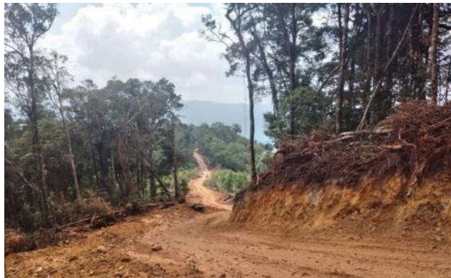
Gambar 17. Jalan di dalam kawasan hutan Suaka Margasatwa Barumun di Sumatra Utara
